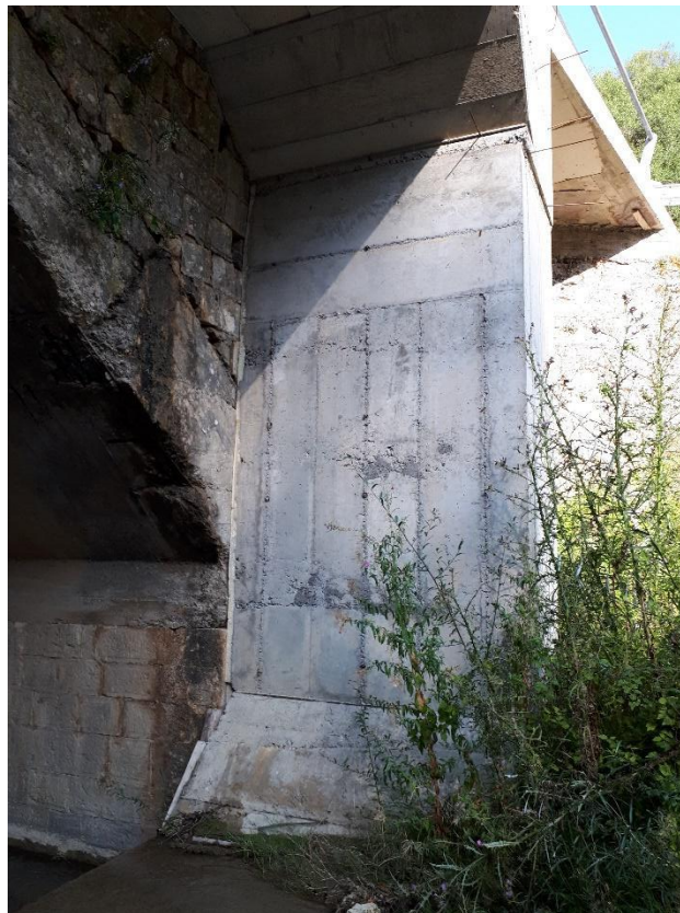
Εικόνα 4. Παράδειγμα ιδανικής θέσης στήριξης αυτόματου σταθμού μέτρησης υδατικών παραμέτρων στη γέφυρα της Καρκαλούς.
